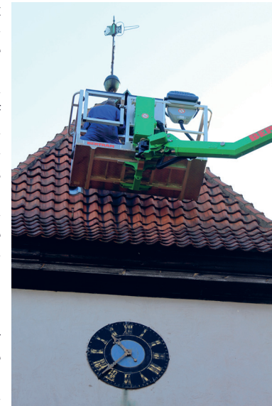
Von der Arbeitsbühne aus gelangt der Techniker in etwa zwölf Metern Höhe an die außen am Turmdach befestigte Uhrglocke.
