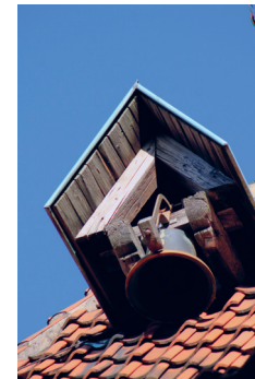
Die Glocke und der Hammer, der zu jeder vollen und halben Stunde gegen die Uhrglocke schlägt, sind jetzt wieder sicher.
