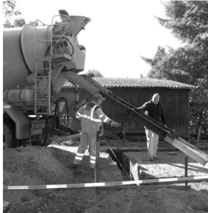
*Für das Toilettenhäuschen werden die Streifenfundamente gegossen*
