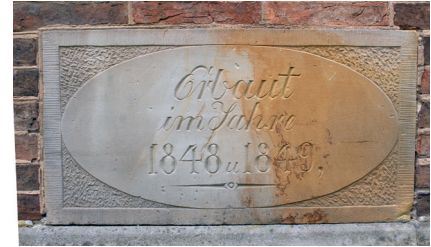
Diese Sandsteintafel an der Ostseite der Kirche verrät das Baujahr 1848/49.
