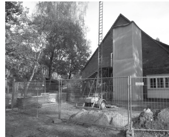
Die Arbeiten für den Eingangsbereich zum Hort machen Fortschritte
