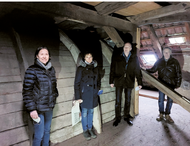
Der Arbeitskreis bei einer Baubegehung der Tonnendecke: Heike Meinheit, Rita Hoheisel, Peter Hartwig und Harald Platte (von links nach rechts). Foto: Anke Kappler
